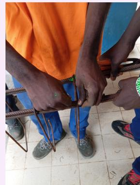
Les élèves ont installé le treillis soudé sur les tréteaux et raccordé l'ensemble avec du fil de fer.
